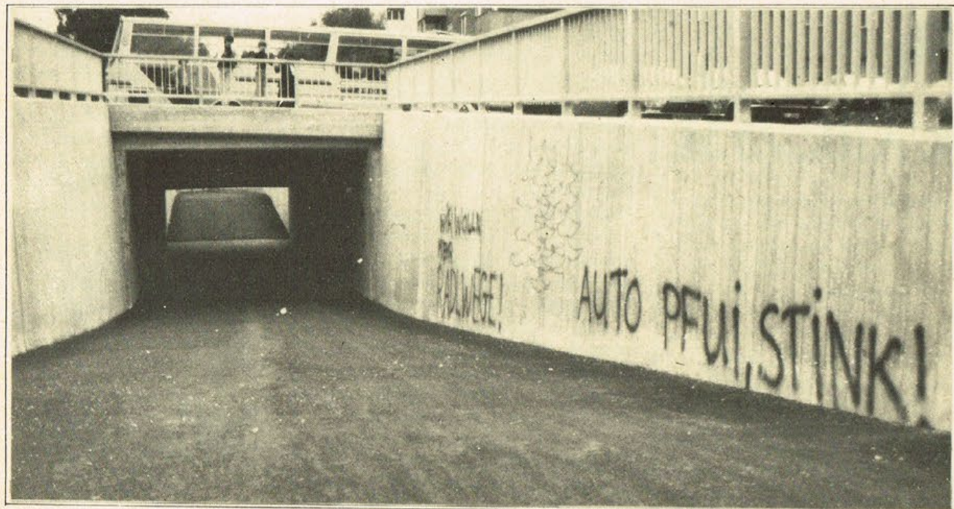
Neue Fußgängerunterführung der Innpromenade (erbaut 1980).
